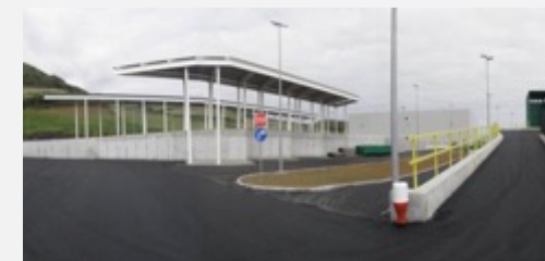
Centro de Processamento de Resíduos da Graciosa
